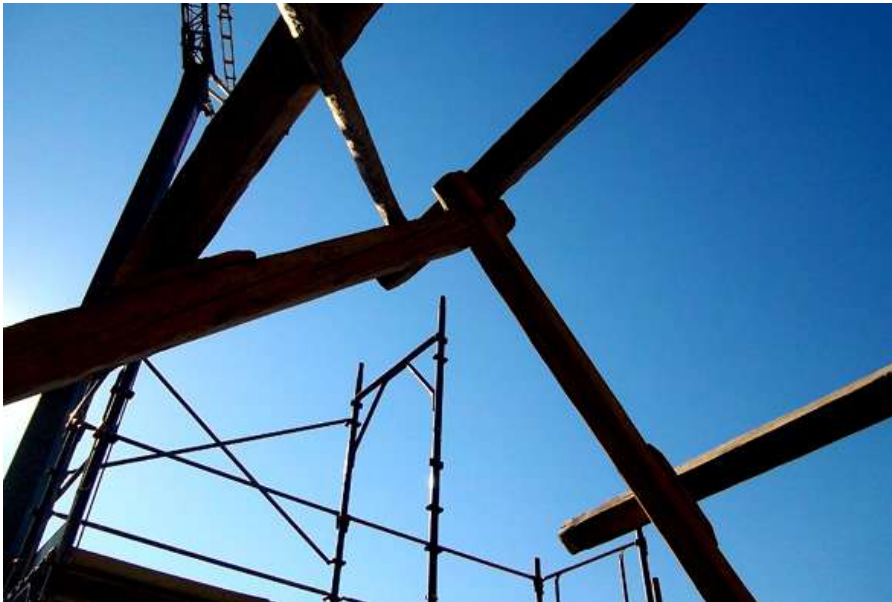
Mantenimento strutture copertura lignea
