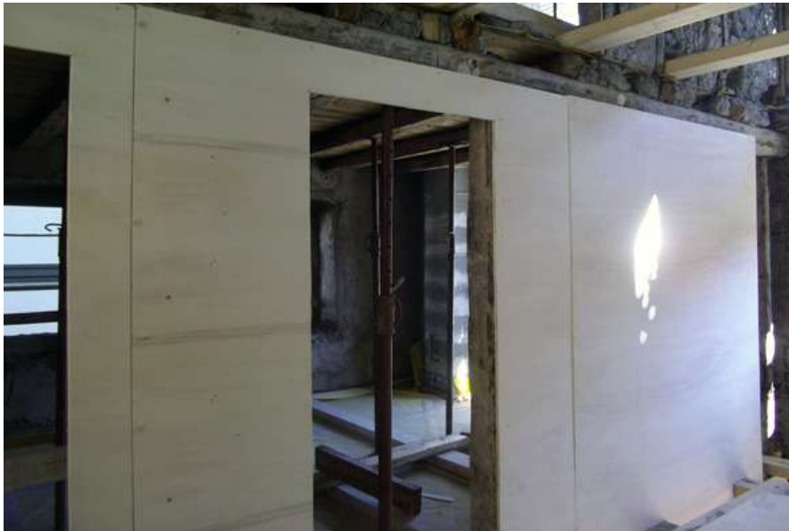
Pannelli di compensato irrigidenti muri intelaiati
