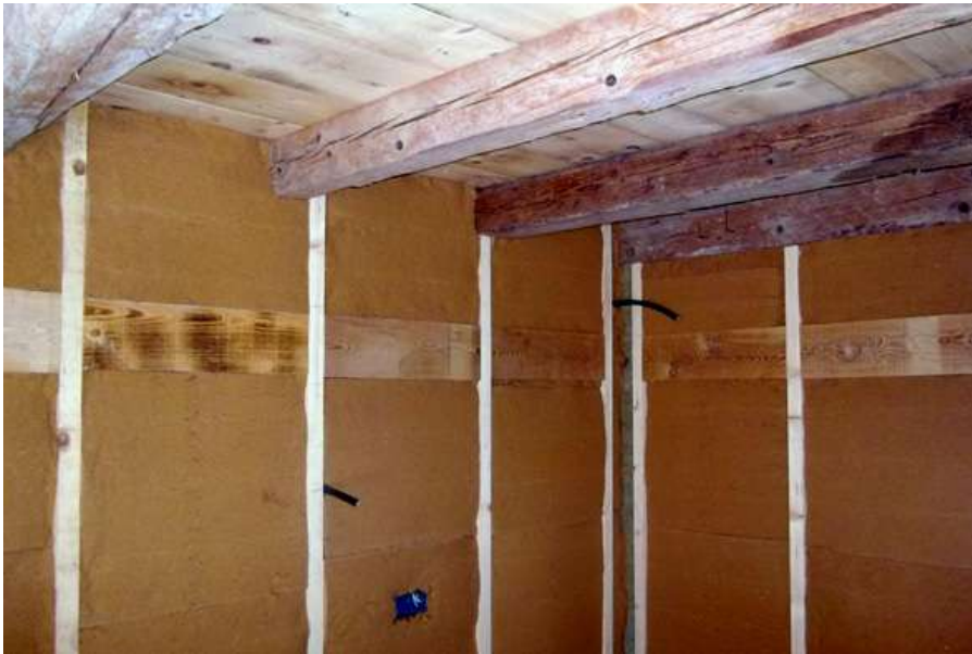
1/3 Isolamento intercapedine impiantistica
