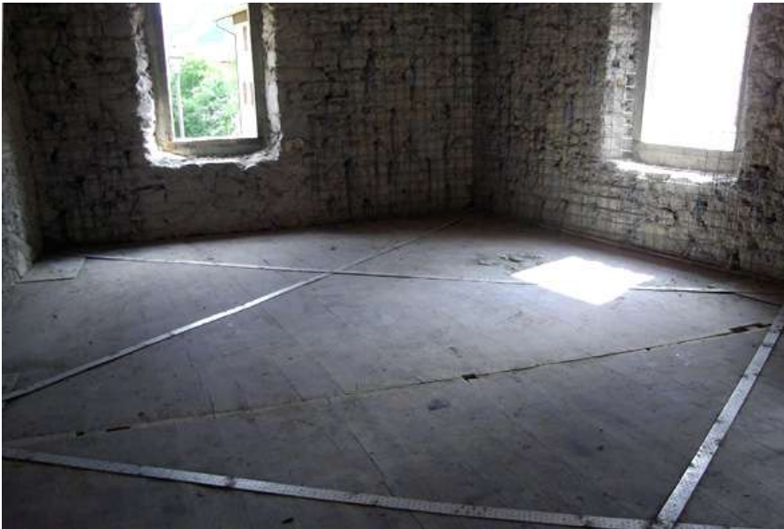
Nastri metallici di controventamento in piano
